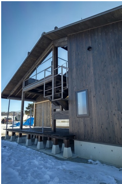
金山デッキの展望デッキと階段。木材がふんだんに使われている。
