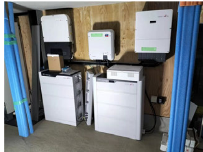
金山デッキの家庭用蓄電池システム。23kW時の容量があるので、停電しても数日は安心だ=スマートソーラー社提供
