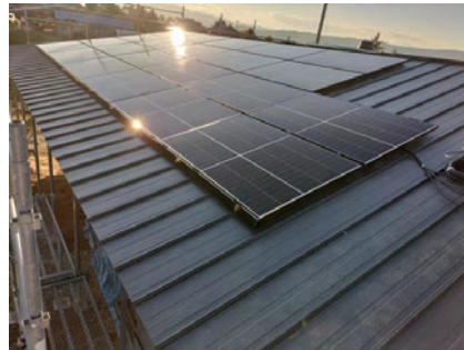
屋根には8.3kW能力の太陽光発電パネルを置いている＝スマートソーラー社提供
